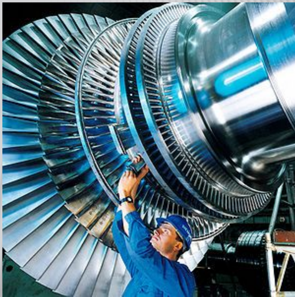
Монтаж паровой турбины, произведённой Siemens , Германия
