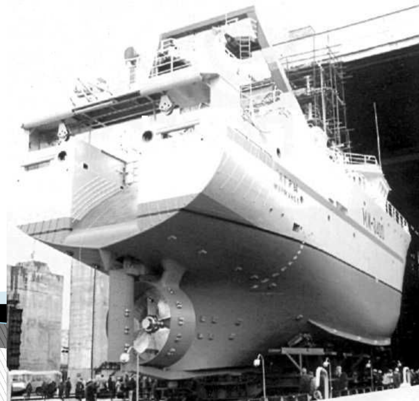
Неподвижная направляющая насадка траулера типа «Ягры»
