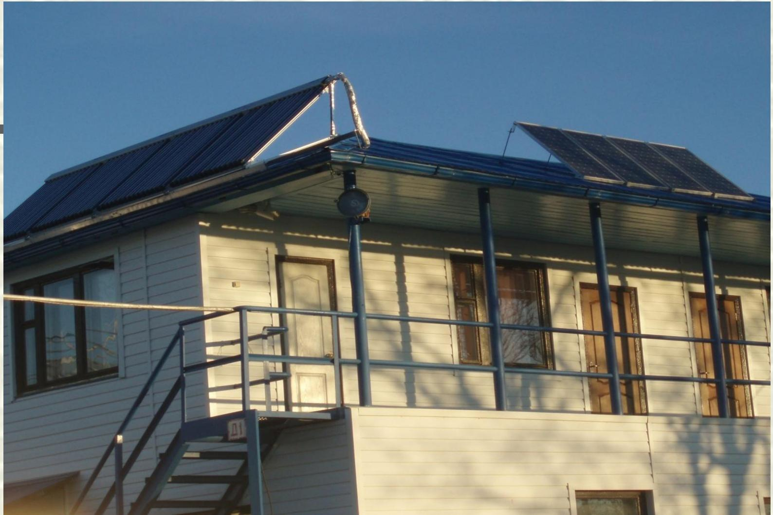
Использование фотоэлектрической установки и солнечного коллектора в системе энергоснабжения административного здания (Ставропольский край).
