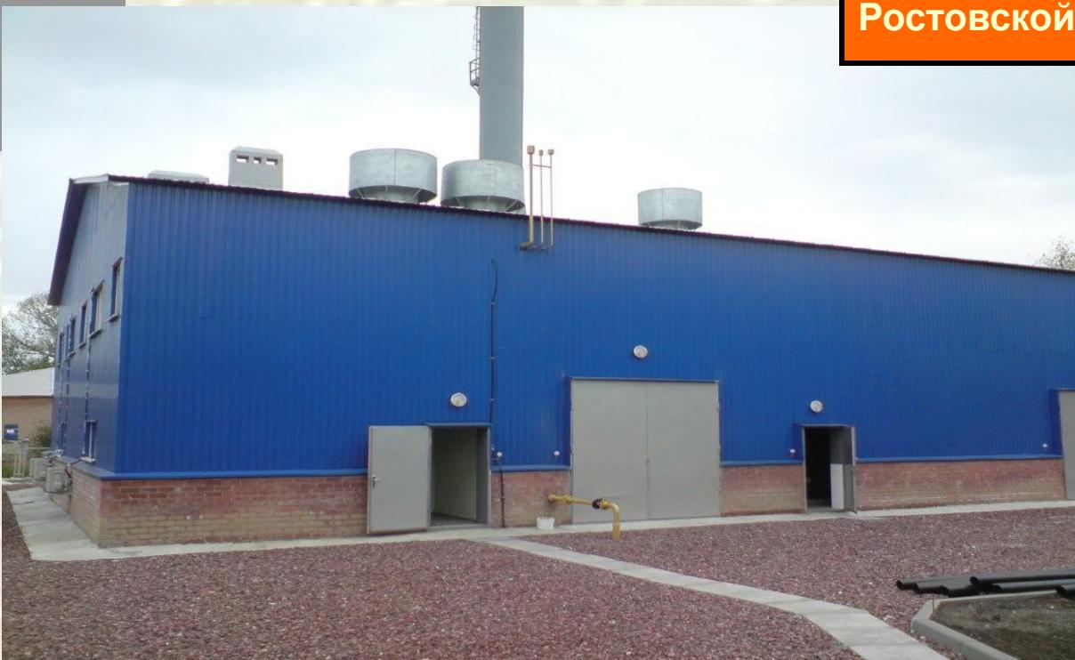
**Станция забирает шахтную воду с температурой 18 °С из скважины с глубины 390 м объемом 100 м<sup>3</sup>/час и сбрасывает отработанную воду, охлажденную до 12 °С, через другую скважину на глубину 100 м. Эта станция обеспечивает теплоснабжение и ГВС зданий социального назначения общей площадью 26,5 тыс. м<sup>2</sup>**
