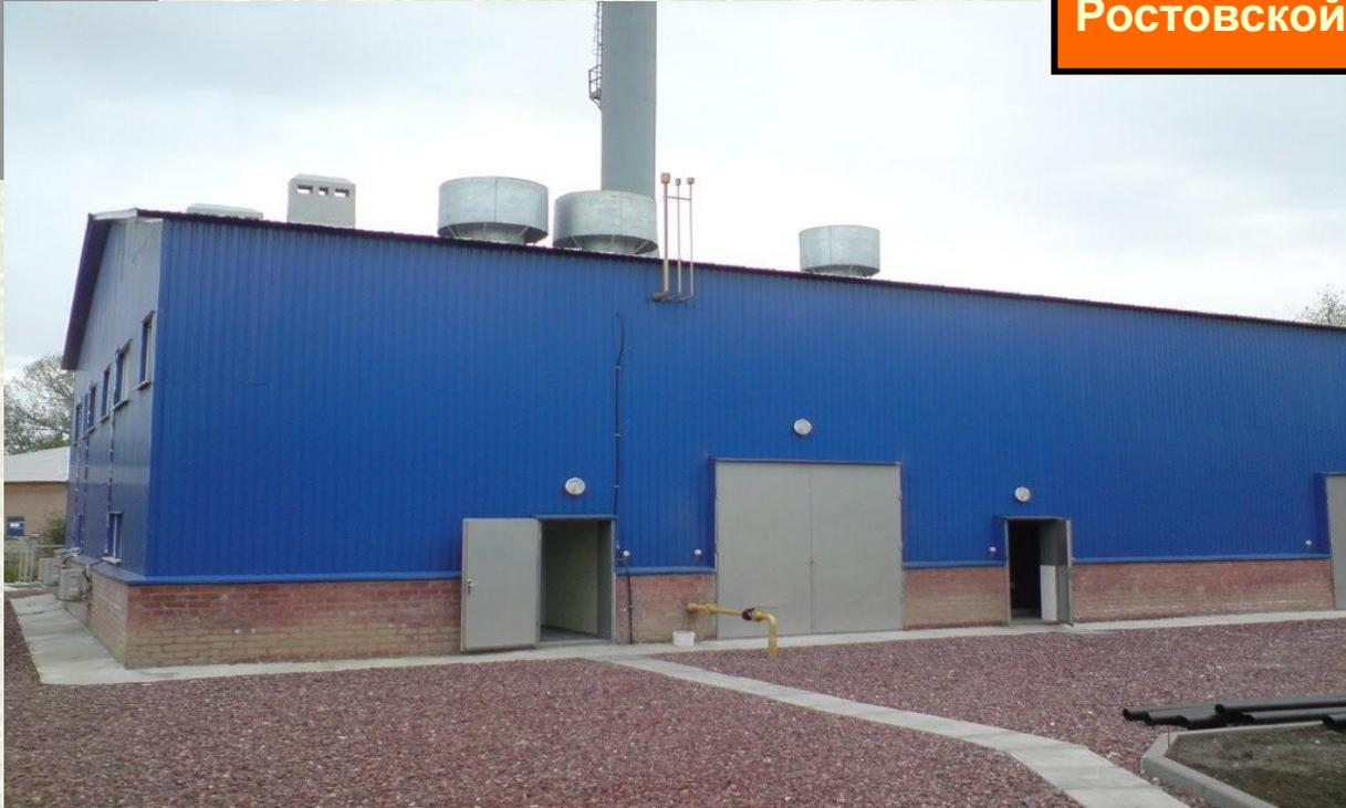
**Станция забирает шахтную воду с температурой 18 °С из скважины с глубины 390 м объемом 100 м<sup>3</sup>/час и сбрасывает отработанную воду, охлажденную до 12 °С, через другую скважину на глубину 100 м.
