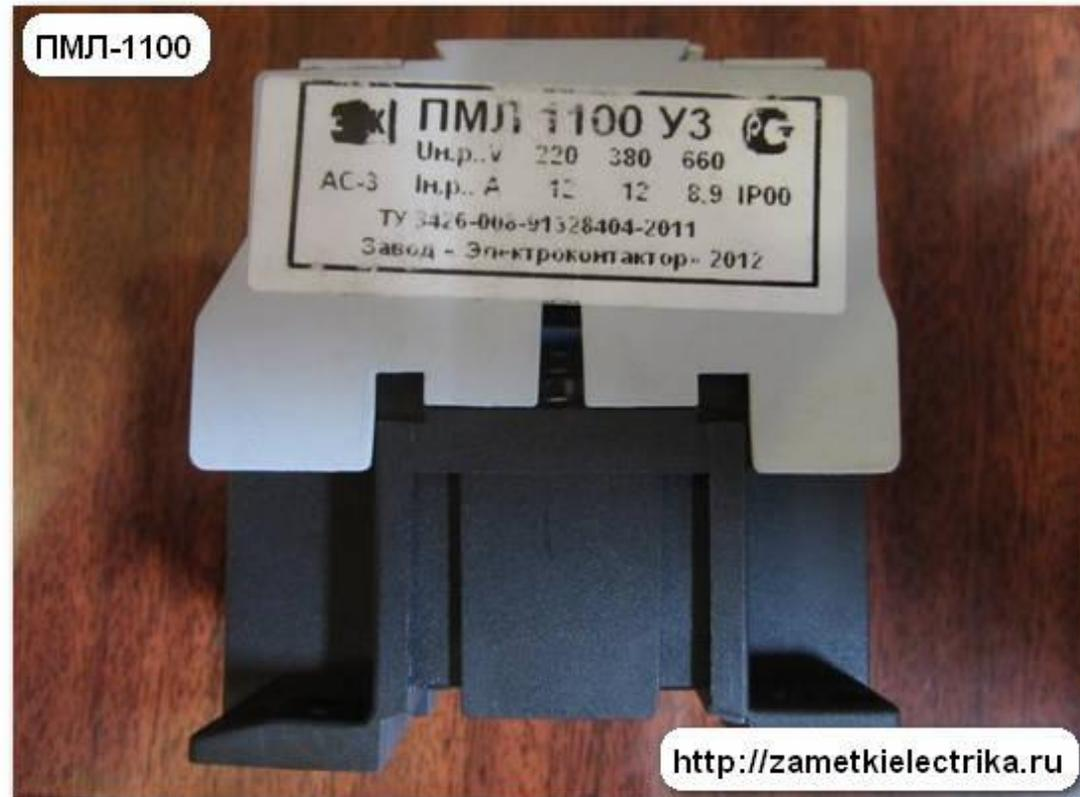
Напряжение катушки пускателя составляет ~220 (В). Это видно по бирке в верхней части пускателя.
