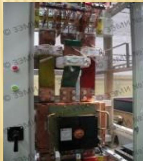
**Панели распределительных щитов серии ЩО-70 предназначены для комплектования РУ напряжением 380/220 В трёхфазного переменного тока частотой 50 Гц с глухозаземленной нейтралью, служащих для приема, распределения электрической энергии, защиты отходящих линий от перегрузок и токов короткого замыкания.**
