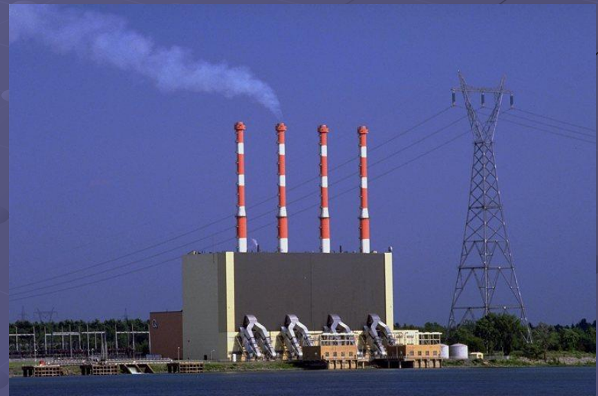
Общий вид ГРЭС
