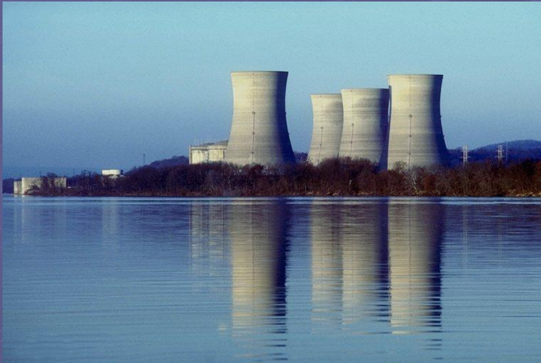
Общий вид АЭС
