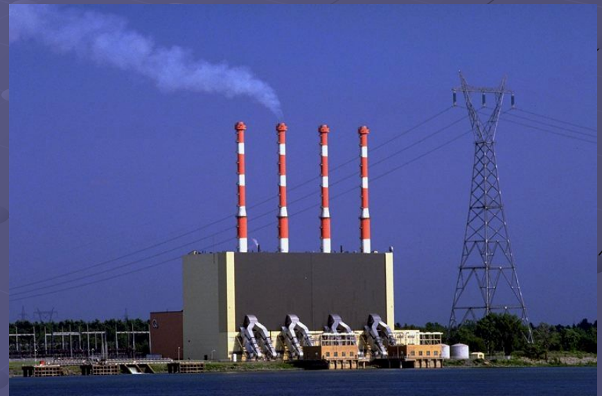
Общий вид ГРЭС
