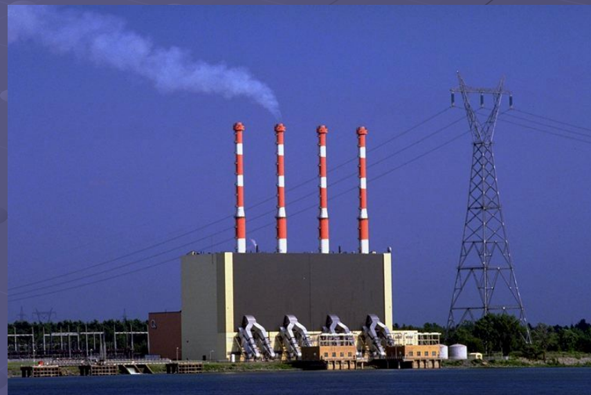
Общий вид ГРЭС
