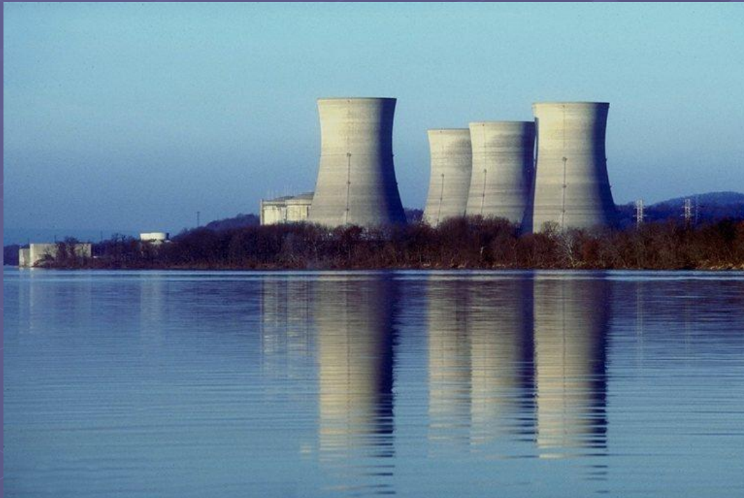
Общий вид АЭС
