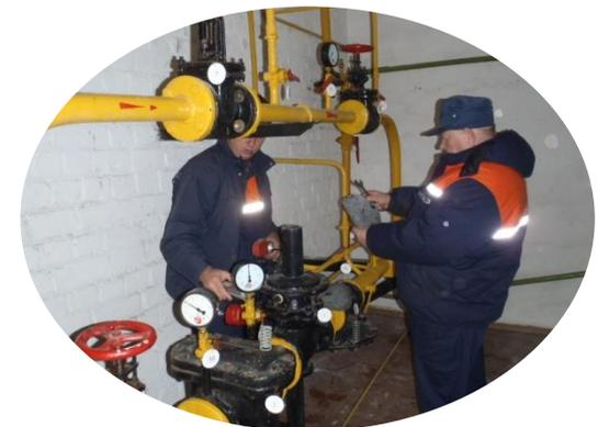
Не обеспечивающие необходимой плотности закрытия задвижки разбирают, очищают их полость от пыли и грязи, также обеспечивают проверку состояния запорных поверхностей и колец и при необходимости их притирают. Задвижку необходимо заменить в случае, если она не обеспечивает необходимой плотности.
