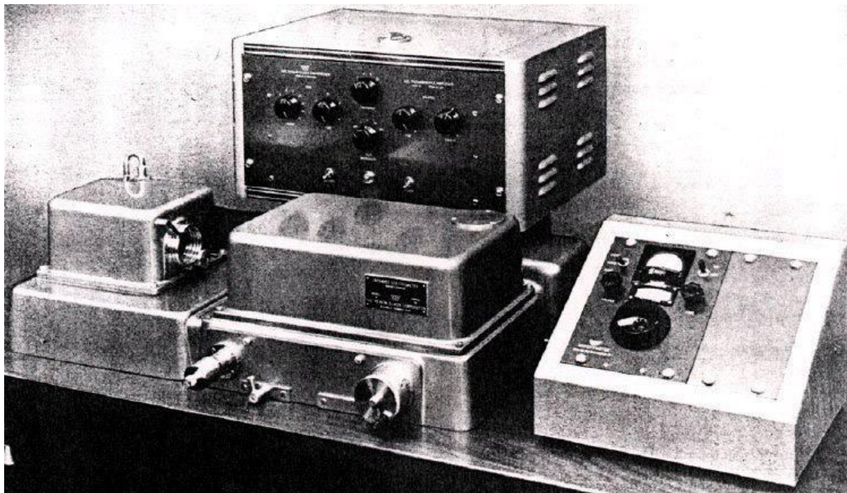
Первый серийный ИК-спектрометр Perkin Elmer Model 12. 1944 г.
