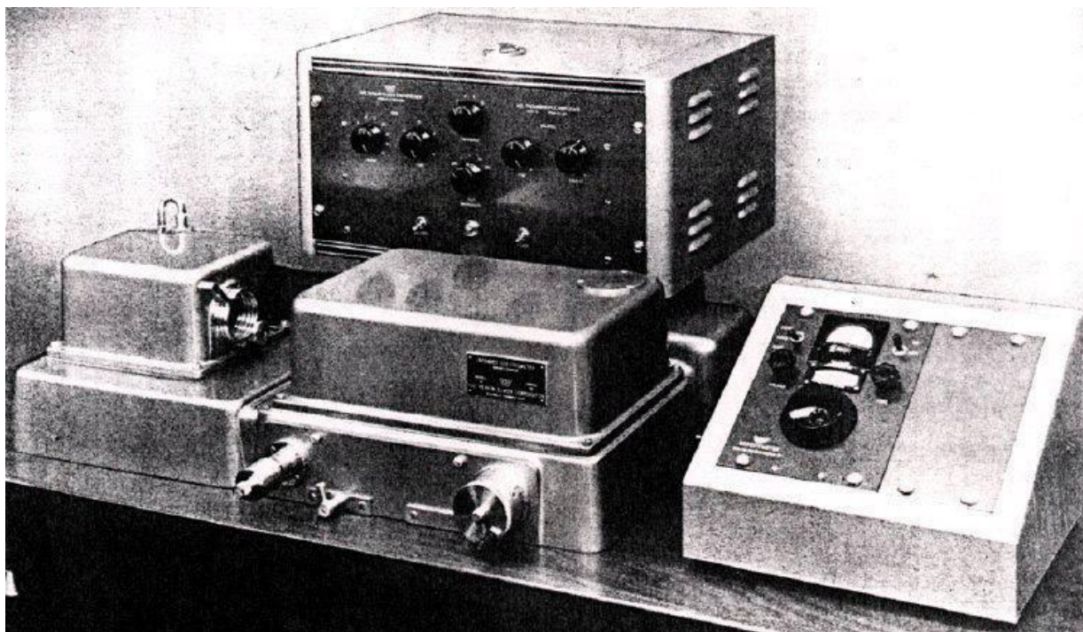
Первый серийный ИК-спектрометр Perkin Elmer Model 12. 1944 г.
