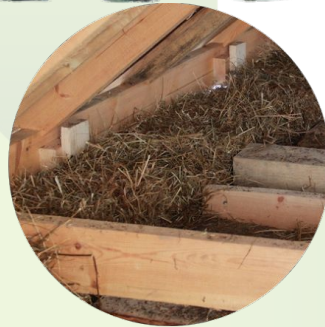
Засыпка в чердачные перекрытия; Известь
