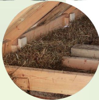
Засыпка в чердачные перекрытие; Известь
