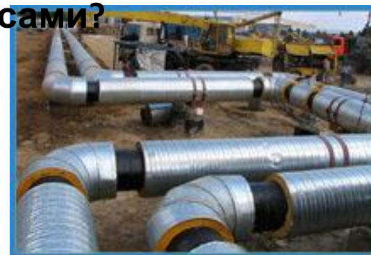
монтаж компенсаторов
