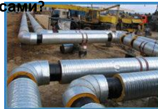
монтаж компенсаторов
