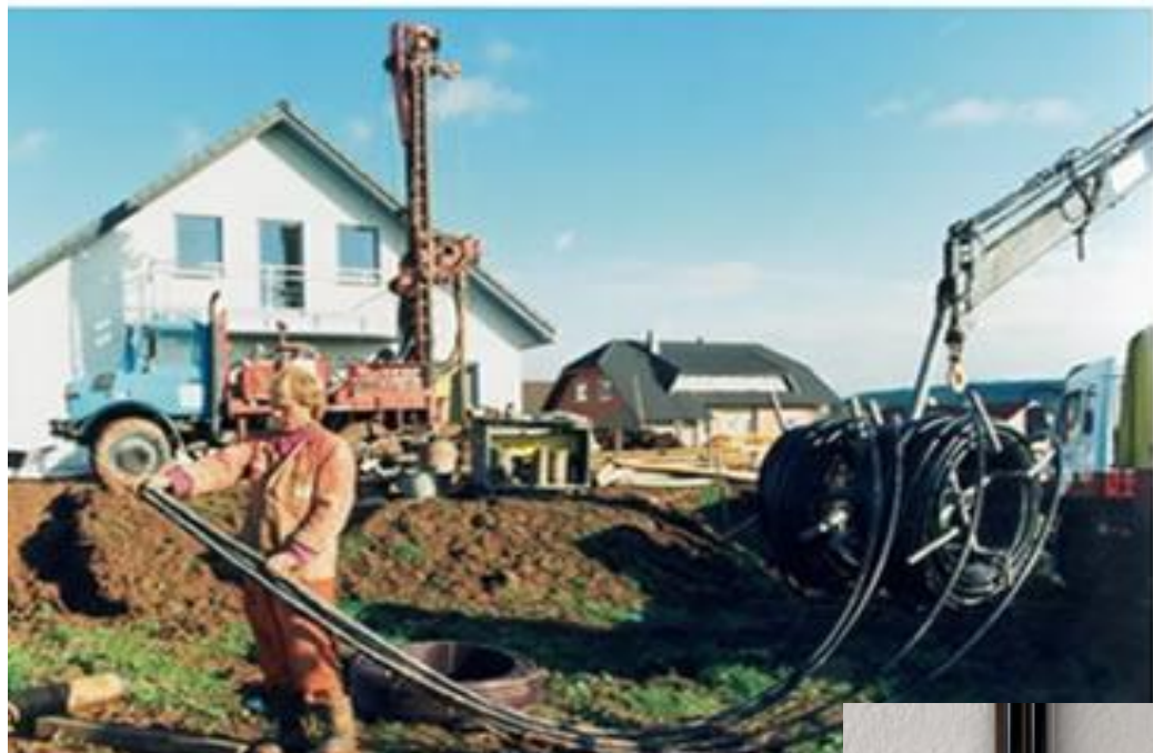
Подготовка двойного U-образного зонда для грунтовой скважины
