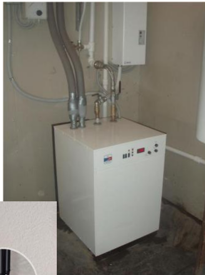
Площадь котельной 2 кв.м.
