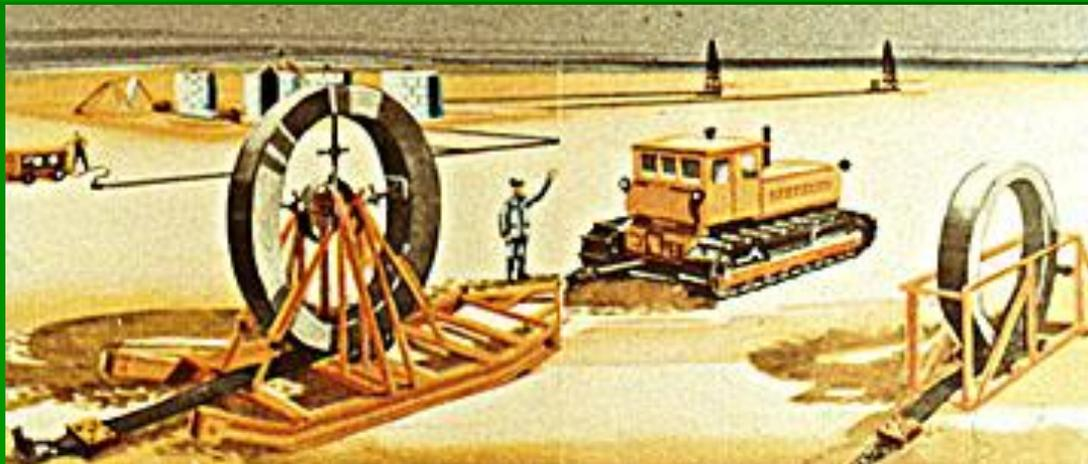
Давление воздуха "раздувает" трубы, изготовленные в виде плоских металлических стальных лент, сваренных по кромкам. Это значительно упрощает прокладку трубопроводов различного назначения.
