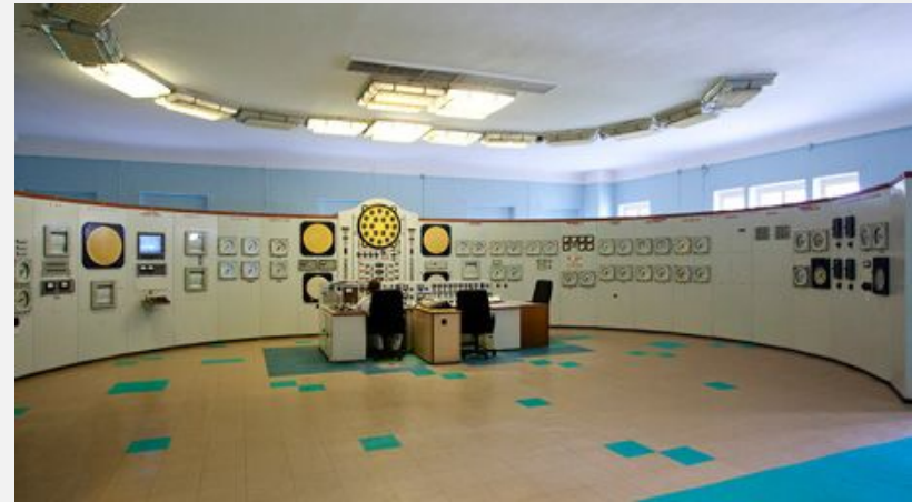
Блок панели управления Обнинской АЭС. Фото: Илья Варламов
