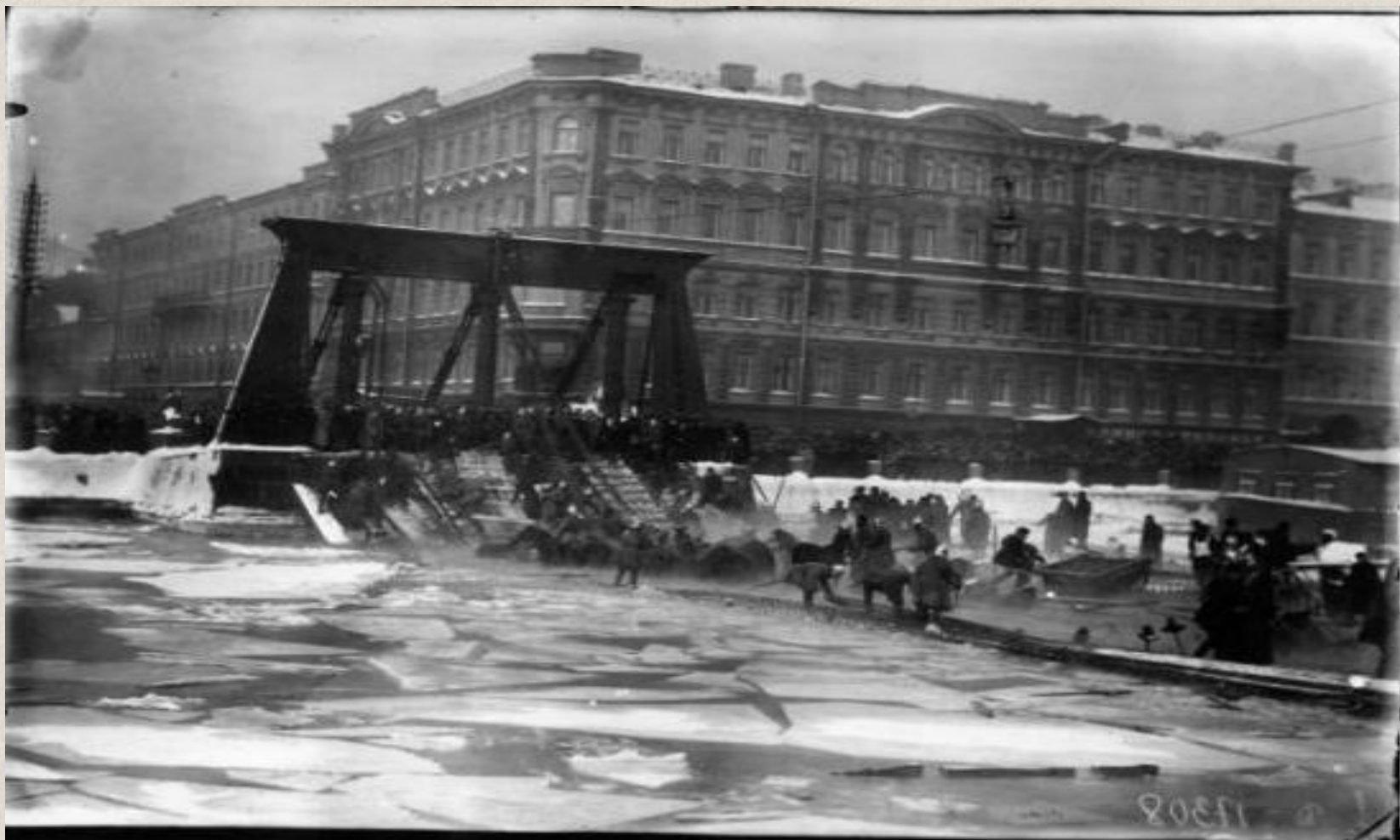
Крушение Египетского моста. 1905г.
