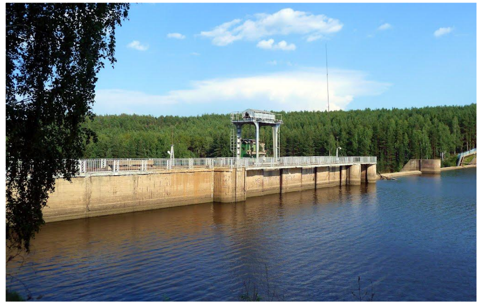
Верхотурская ГЭС. Свердловская область
