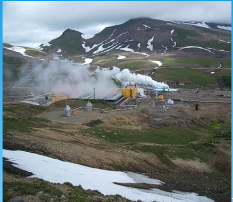
Мутновская геотермальная станция
