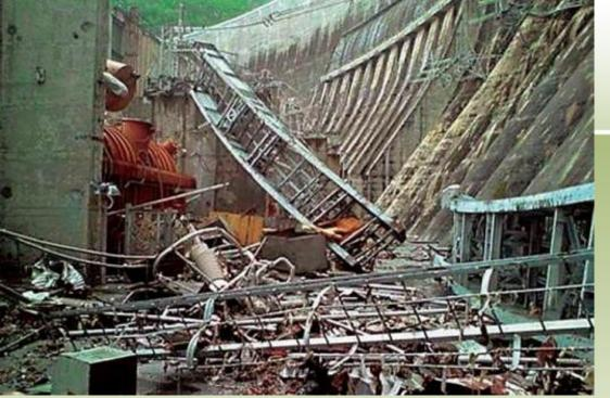
В 8:13-8:15местно времени 17 августа 2009 года на станции произошла авария на гидроагрегате № 2 с его разрушением и поступлением большого количества воды в помещение
