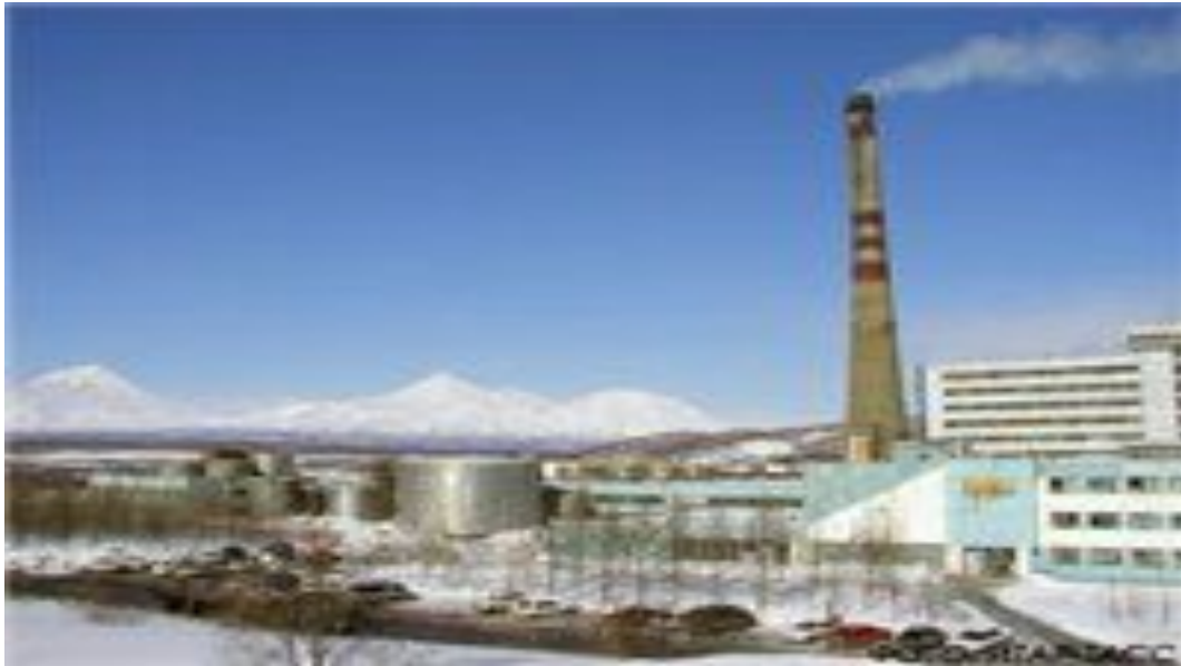
Паужетская геотермальная станция
