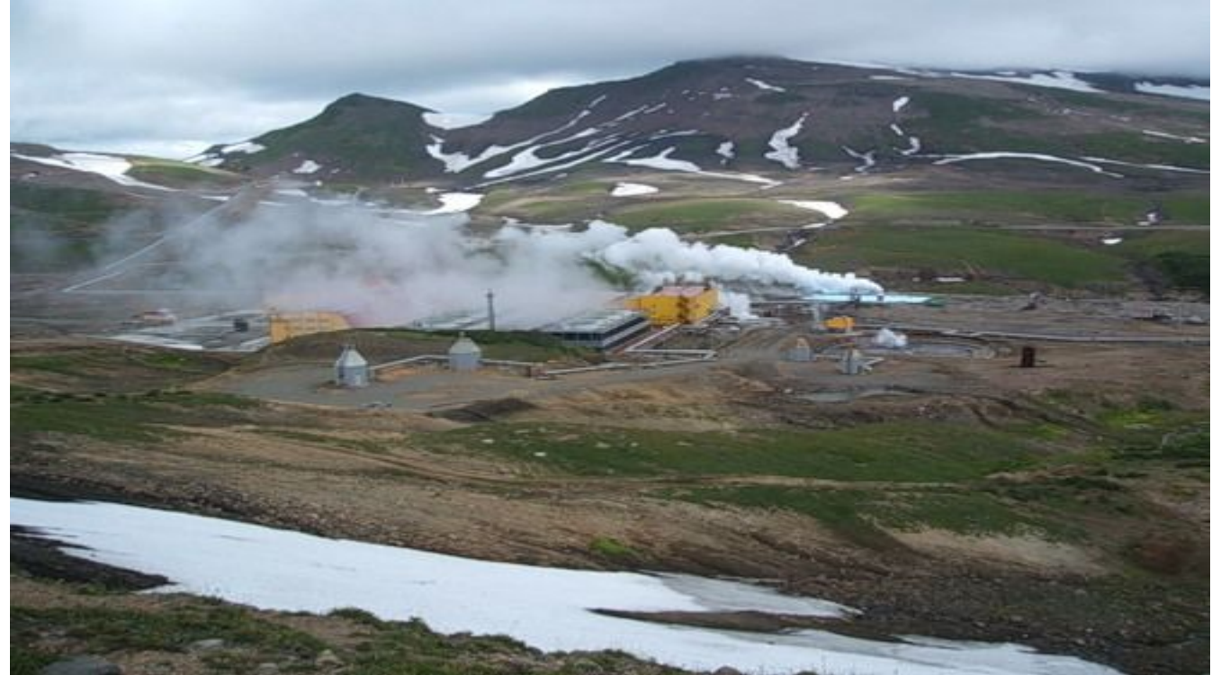
Мутновская геотермальная станция
