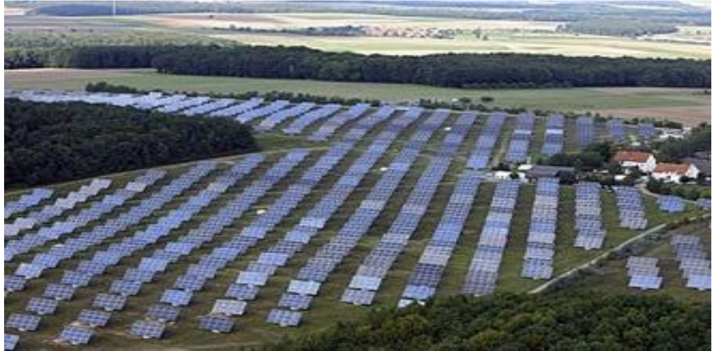
Солнечная электростанция в Германии
