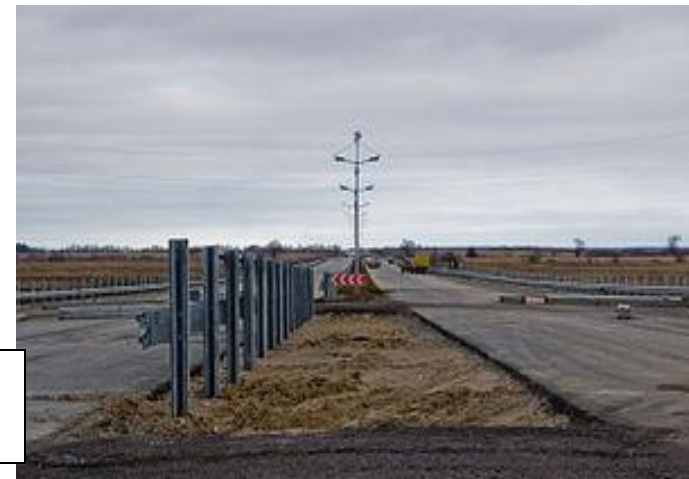
Рис. 10. Участок строящейся трассы « Приморское кольцо »
