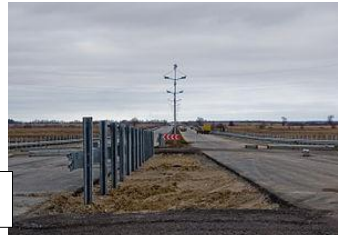
Рис. 10. Участок строящейся трассы « Приморское кольцо »
