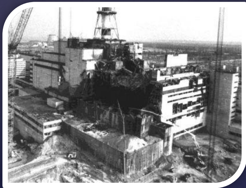
Разрушенный 4-й энергоблок
