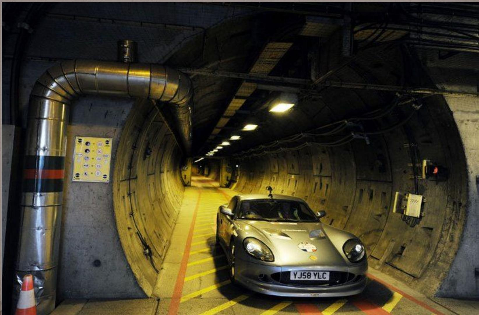
**Диаметр тоннелей — 7,3 метра, длина каждого тоннеля — около 50 километров, из которых 38 проходят под толщиной воды.**
