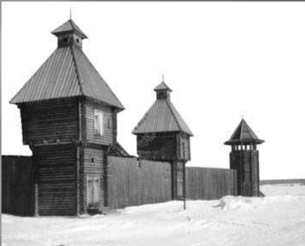
Фрагмент реконструированной крепостной стены
