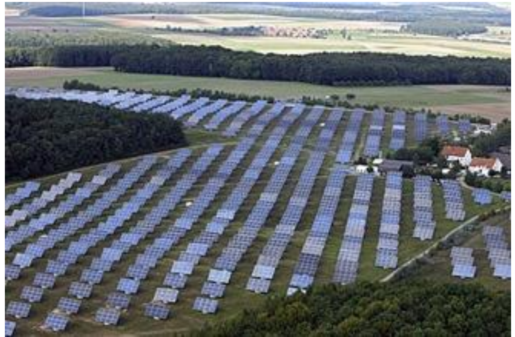
Солнечная электростанция в Германии
