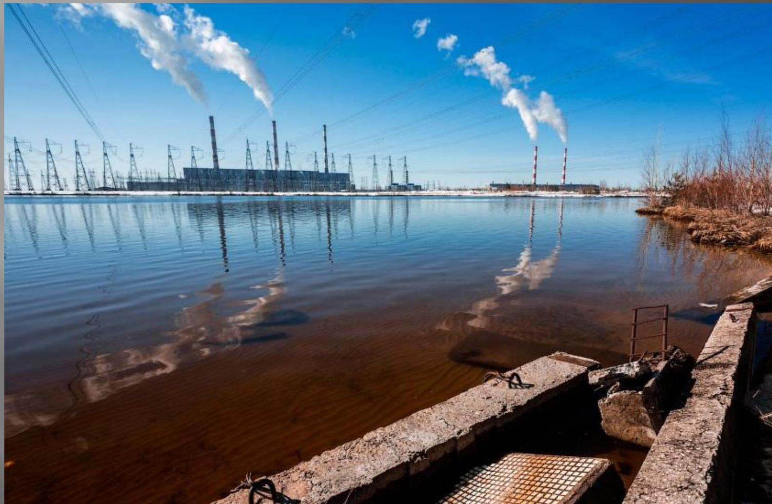
Сургутская ГРЭС-2 работает на попутном нефтяном газе (70%) и природном газе (30%), это делает её более экологичной, в сравнении с любой другой ТЭС, работающей на угле. Потому что: во-первых, газ – самый чистый вид топлива, который в отличие от угля, не дает сажи. Во-вторых, газ, который поступает на самую мощную ТЭЦ в России, проходит серьезную очистку. Прежде чем его направить в котел, из него извлекается сера и другие примеси.
