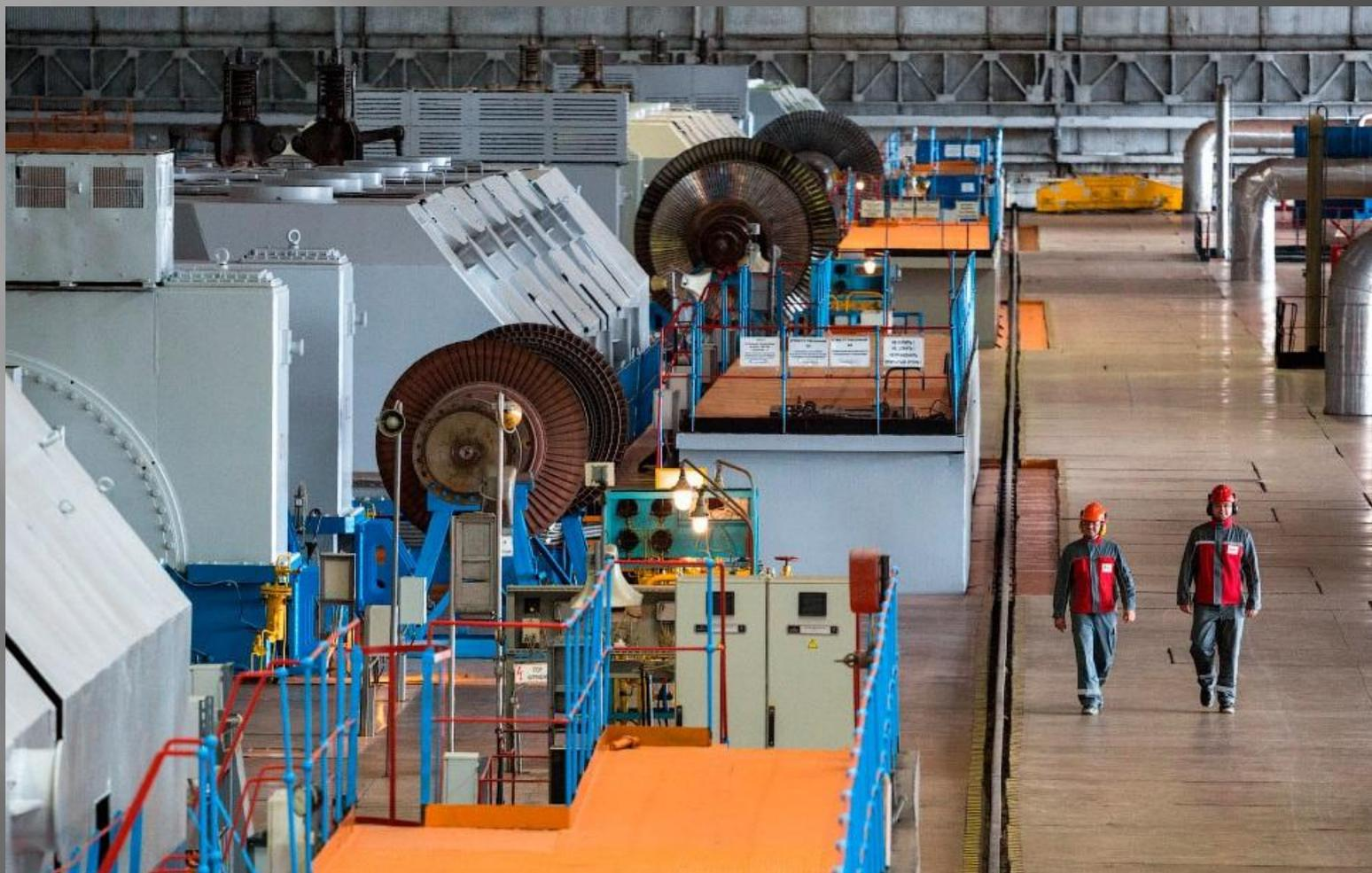
Переместимся в энергоблоки. На фото паровая турбина типа D10 GE мощностью ~400 МВт. Таких турбин здесь две. Паровые котлы не видны, т. к. они полностью закрыты.
