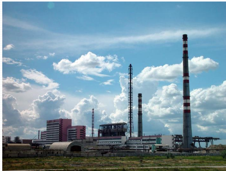
Красноперекопский бромный завод
