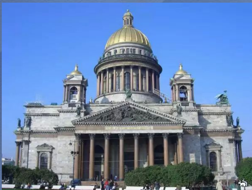
Исаакиевский собор в Санкт-Петербурге
