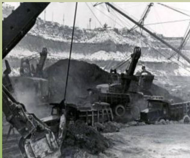
Вскрышные работы перед первым взрывом
