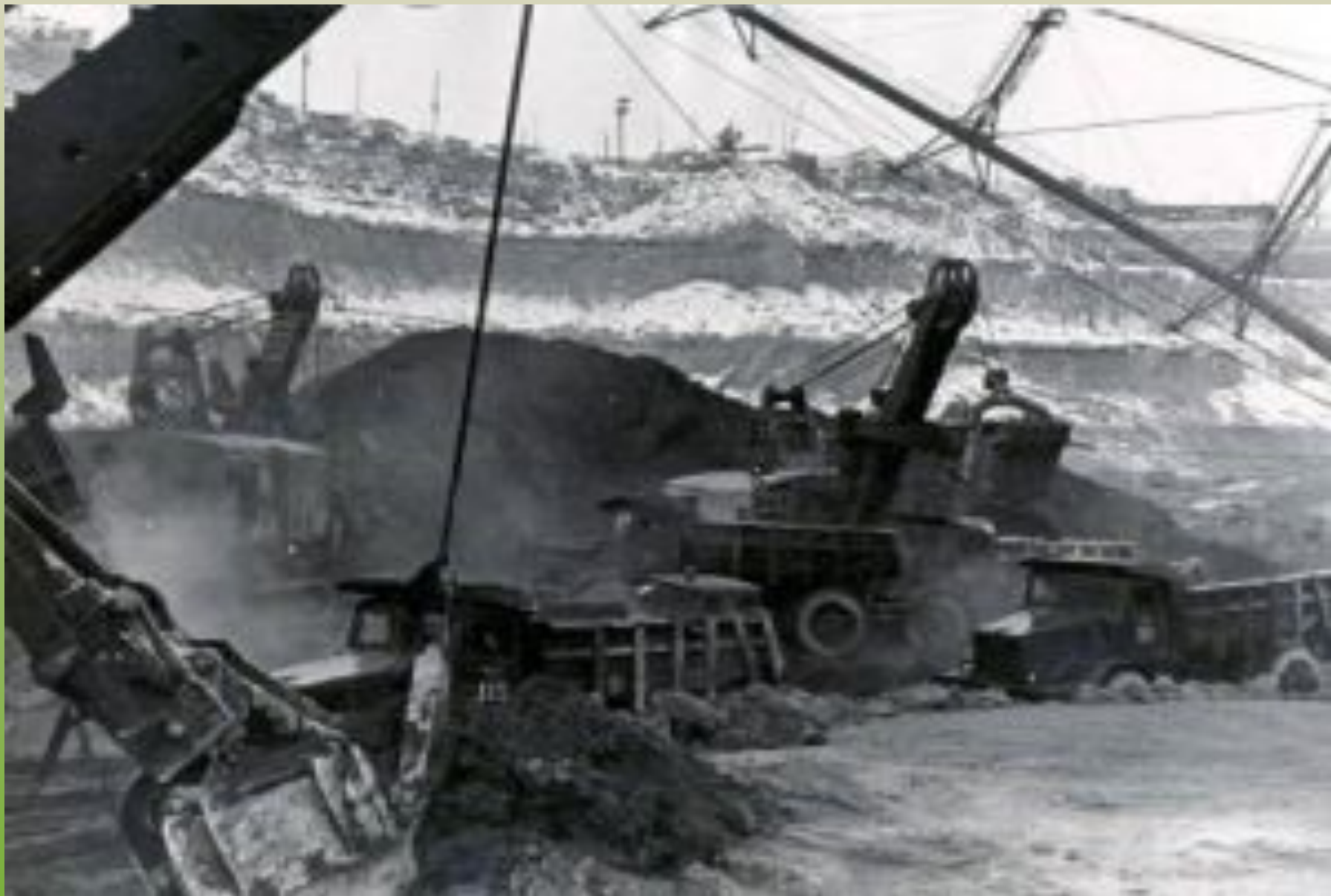
Вскрышные работы перед первым взрывом
