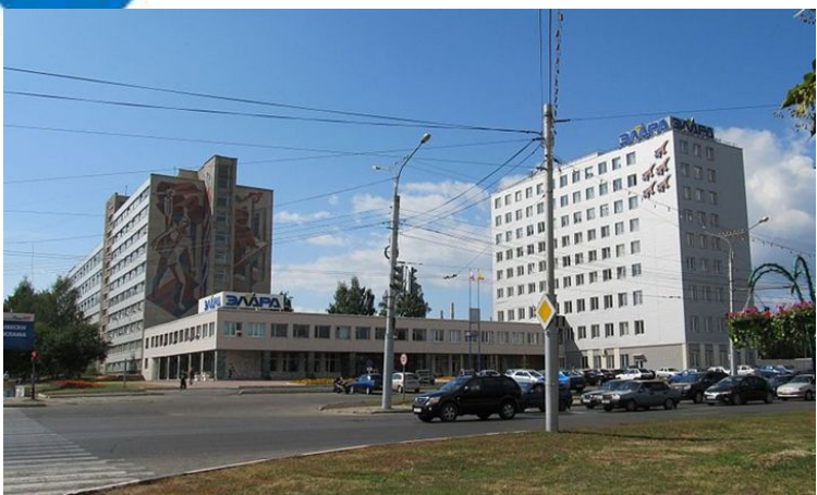
Чебоксарский приборостроительный завод
