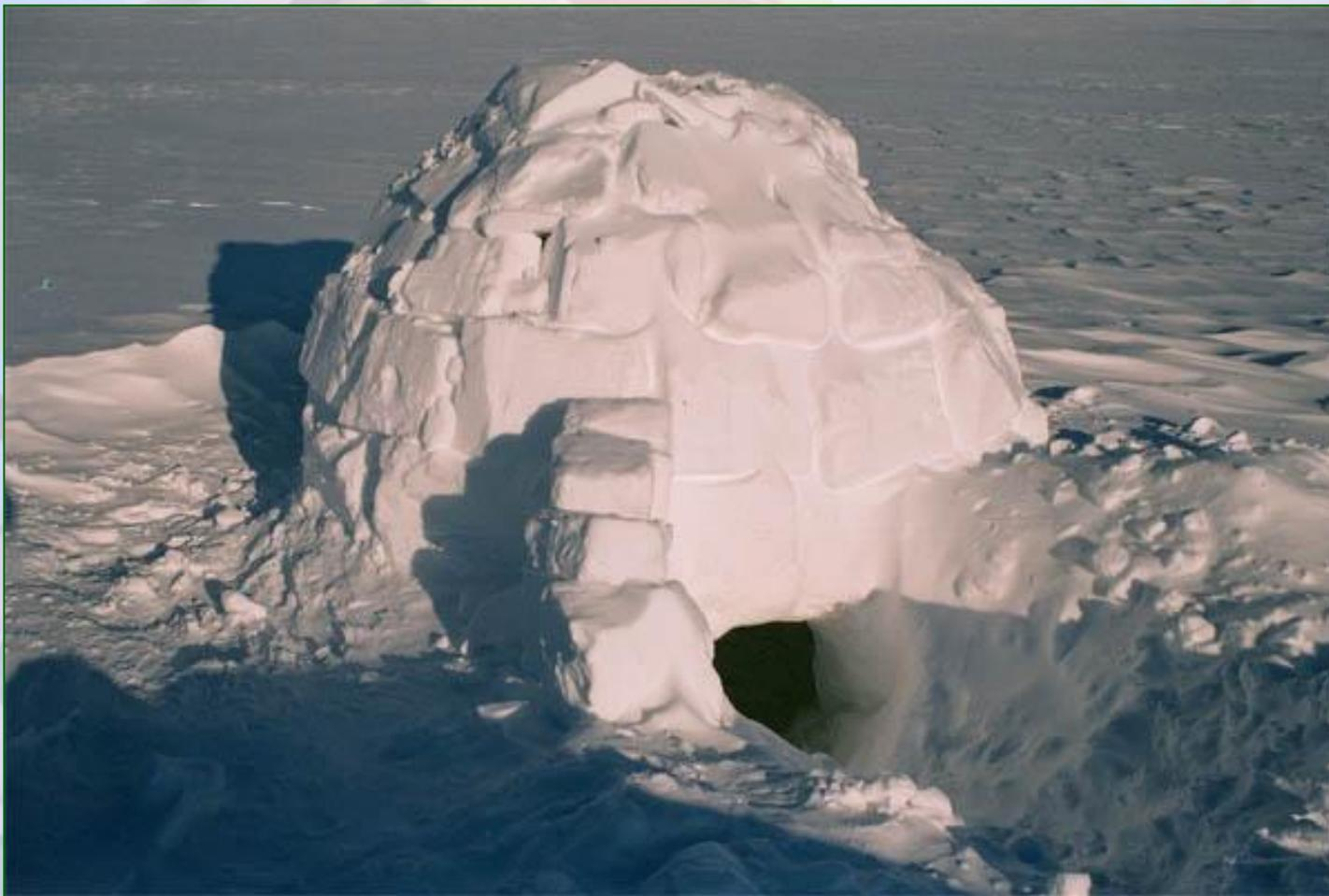
Жилище эскимосов, построенное из глыб снега, который благодаря своей пористой структуре является хорошим теплоизолятором. Эскимосы сооружают иглу на два-три человека за полчаса.
