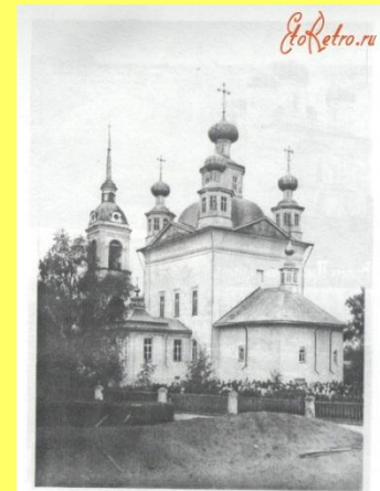
Фото 5. Троицкий собор. Вид со стороны алтарной части
