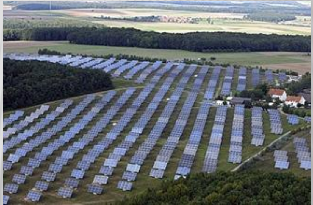
Солнечная электростанция в Германии
