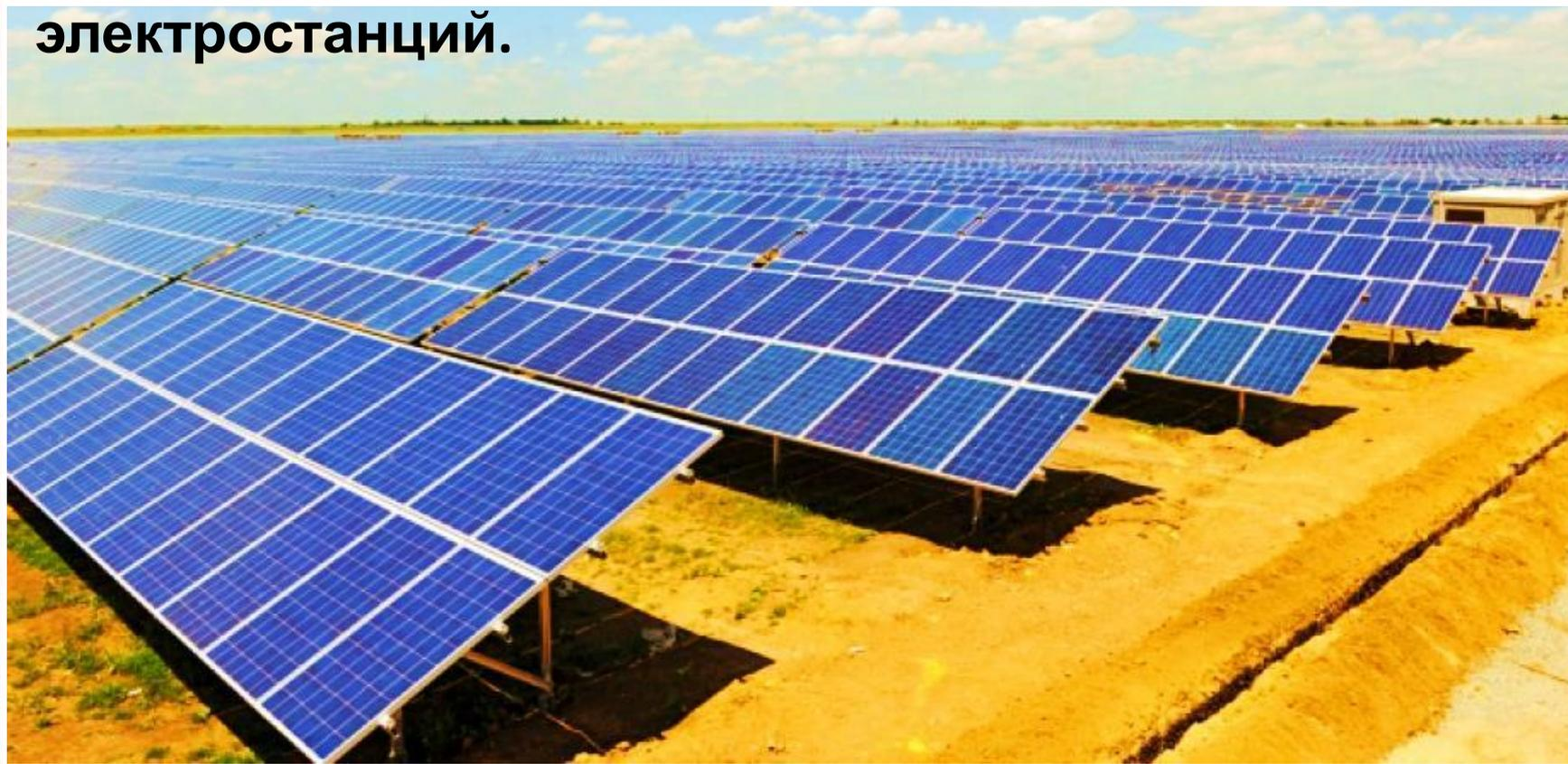
Наиболее распространены станции, использующие фотоэлектрические преобразователи (фотоэлементы), объединенные в солнечные батареи. Большинство крупнейших фотоэлектрических установок мира находятся в США.
