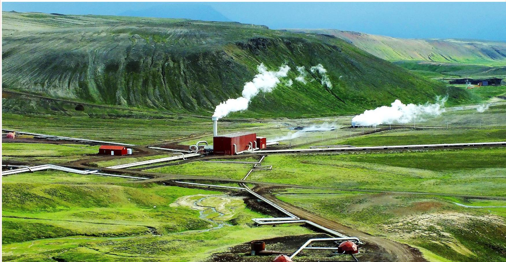
**Геотермальные станции** устроены относительно просто, здесь не требуется топливо, золоуловители. Пар, откачиваемый из скважин, поступает в турбины и приводит в действие электрогенераторы.
