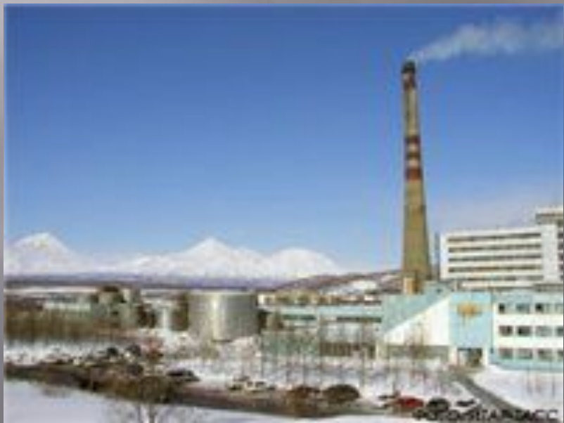
Паужетская геотермальная станция
