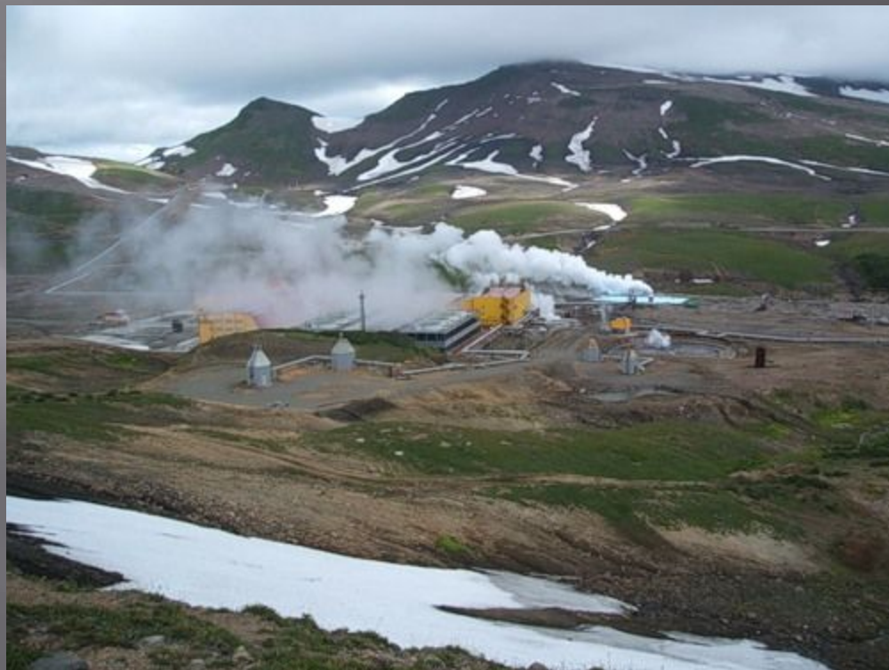
Мутновская геотермальная станция
