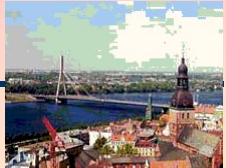
Рига.Мост через Даугаву
