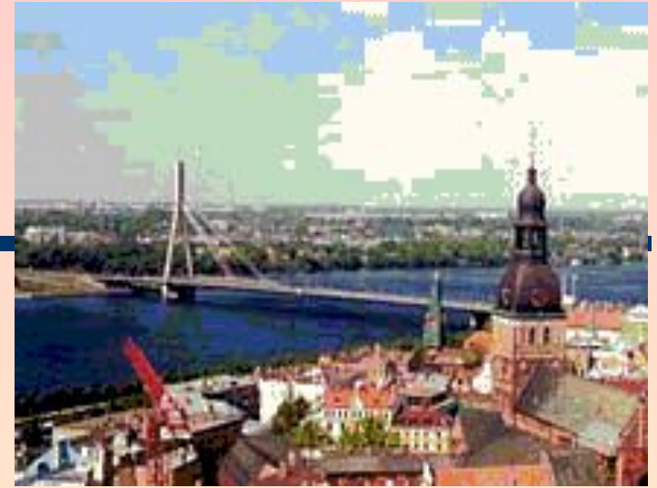
Рига.Мост через Даугаву
