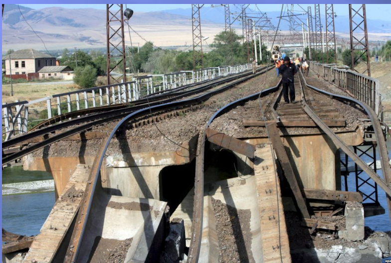
Остатки железнодорожного моста через р.Ингур
