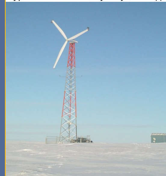
Турбина на 50 кВт, Нунавут, Канада
