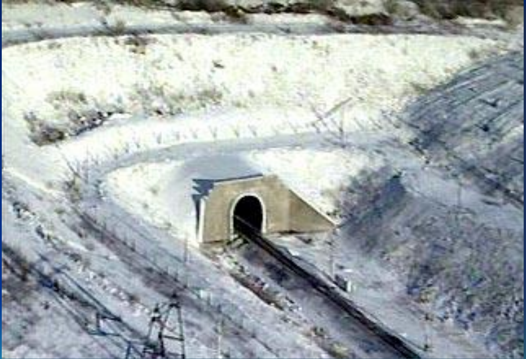
Северо-Муйский тоннель. Его протяжённость более 15 километров
