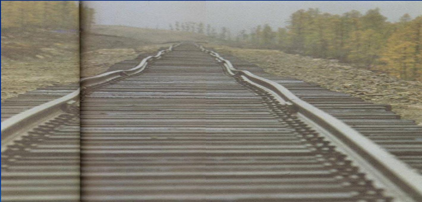
Повреждение полотна при таянии многолетней мерзлоты
