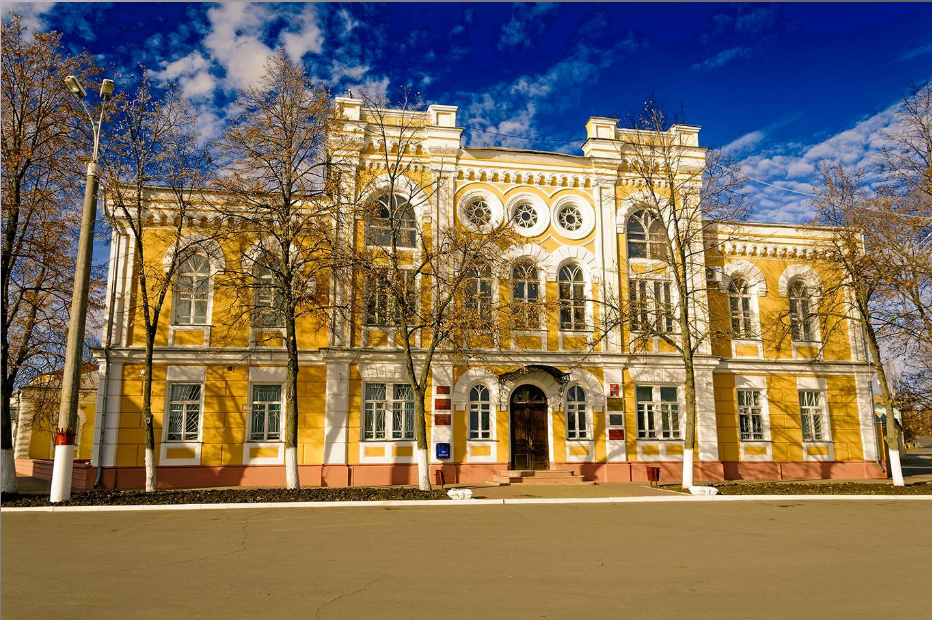
Управа уездная земская. Здание построено в 1882 году. Архитектор В.Е. Переверзев
