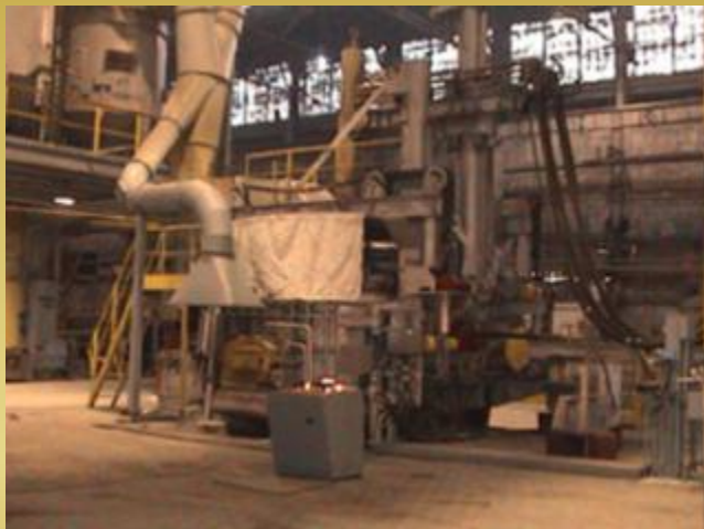
Заводы передельной металлургии
