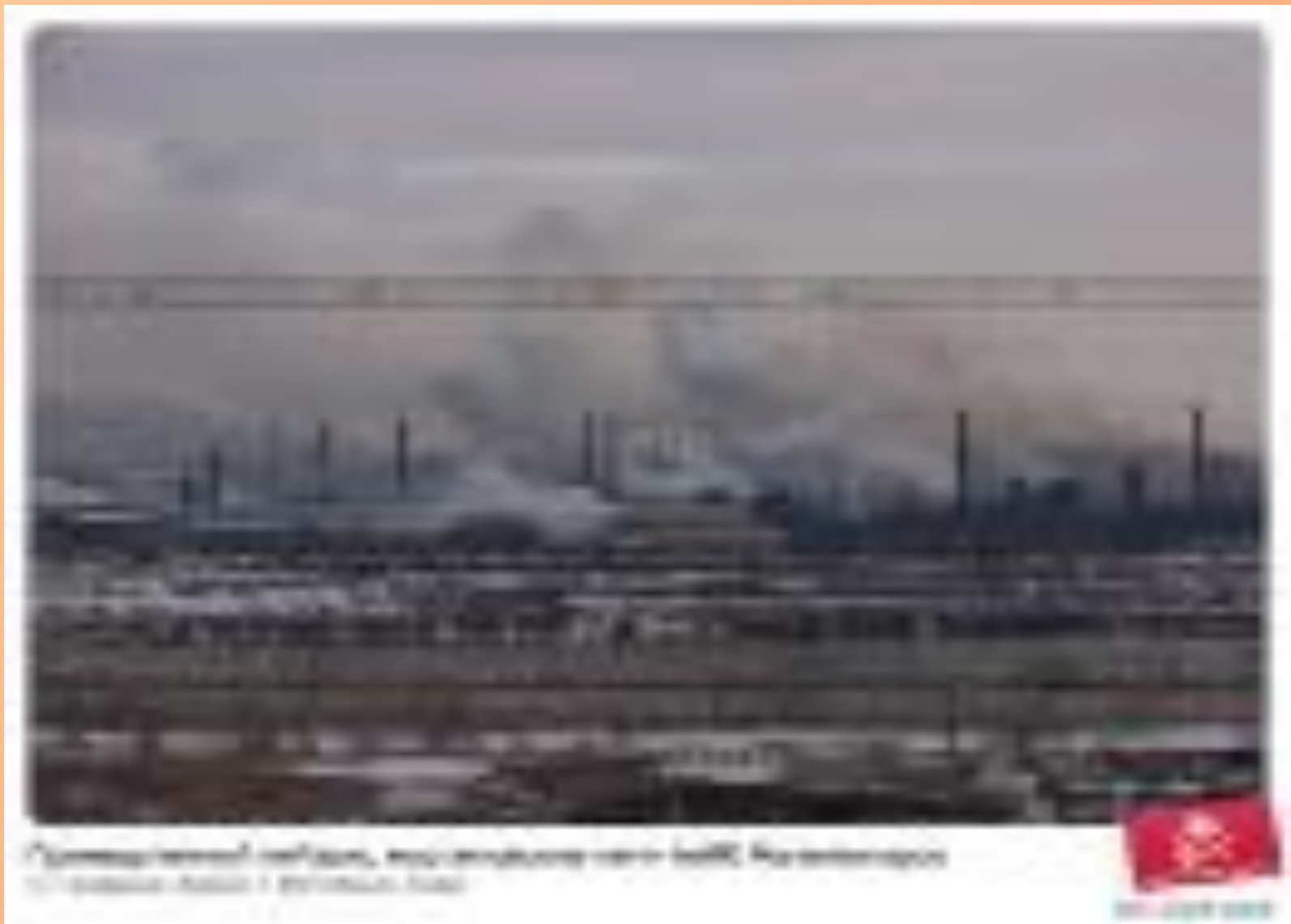
Общий вид металлургического комбината
