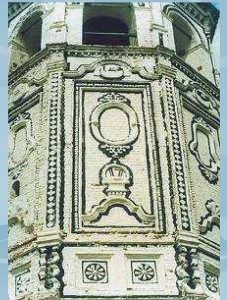
Колокольня церкви Николы Гостинного
