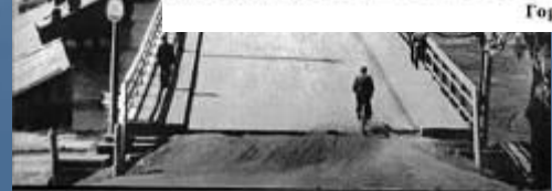
Мост через Клязьму
