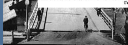
Мост через Клязьму
