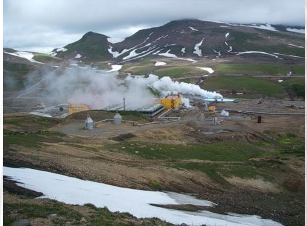
Мутновская геотермальная станция
