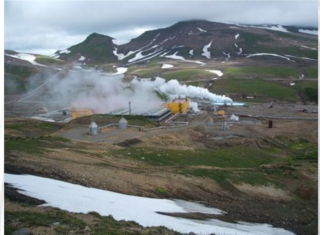
Мутновская геотермальная станция
