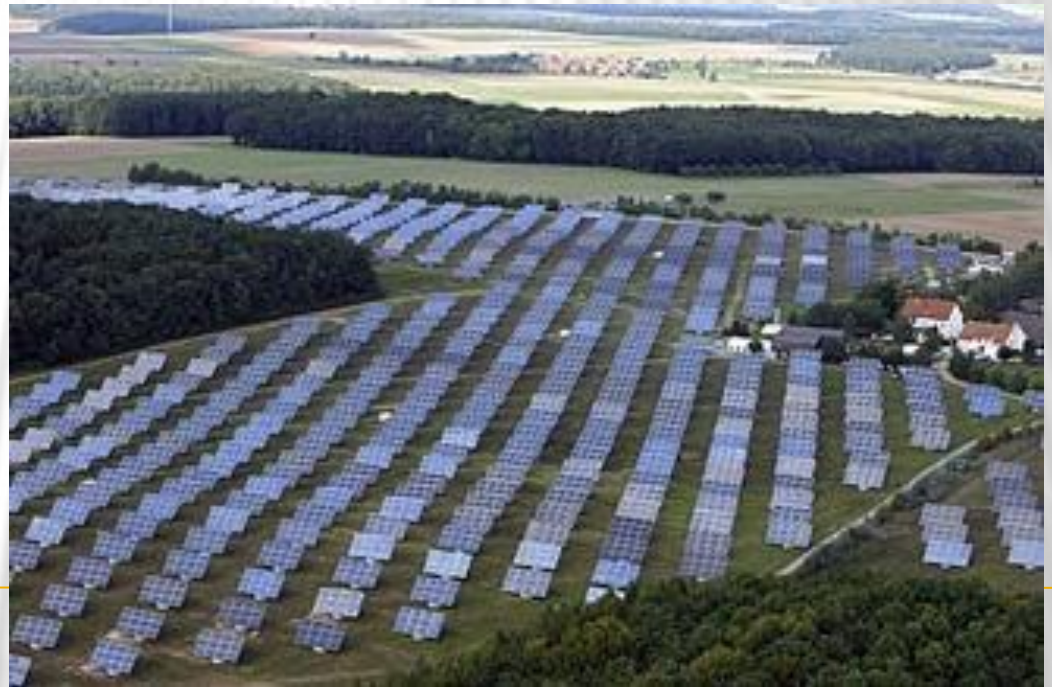
Солнечная электростанция в Германии
