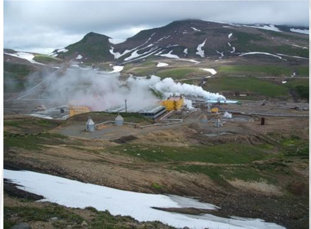
Мутновская геотермальная станция
