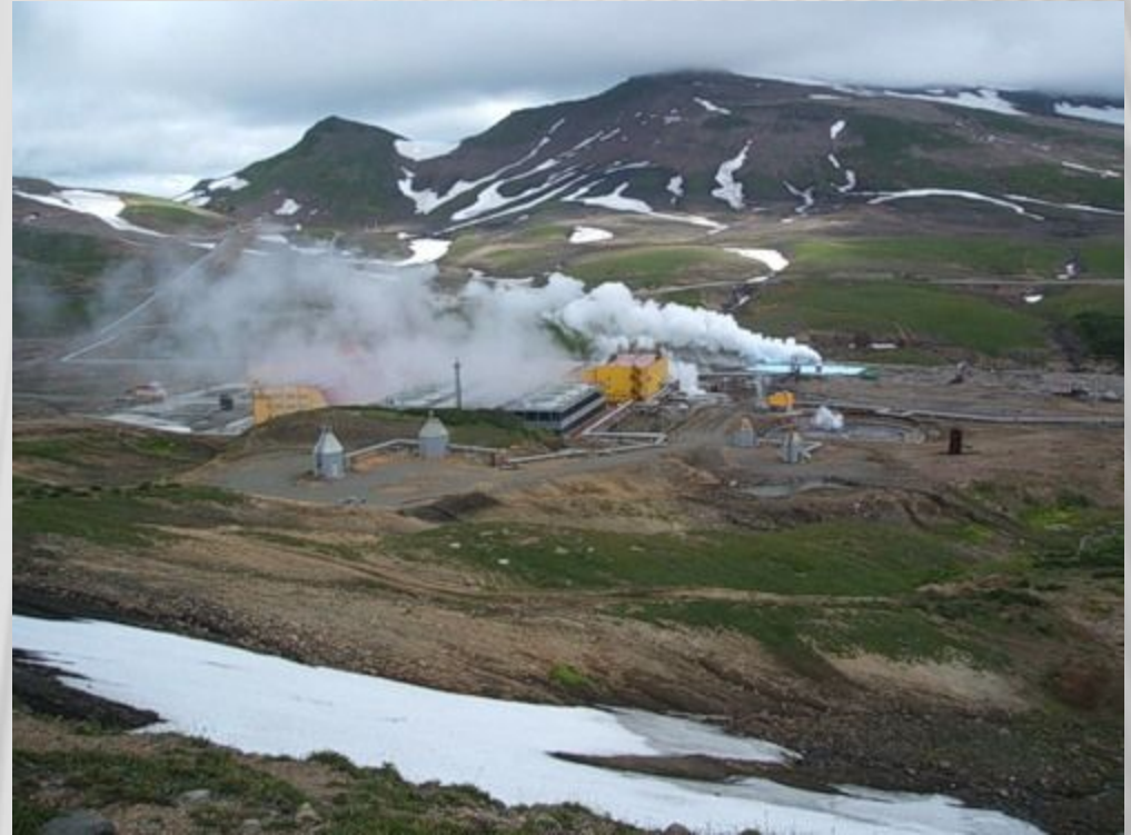
Мутновская геотермальная станция
