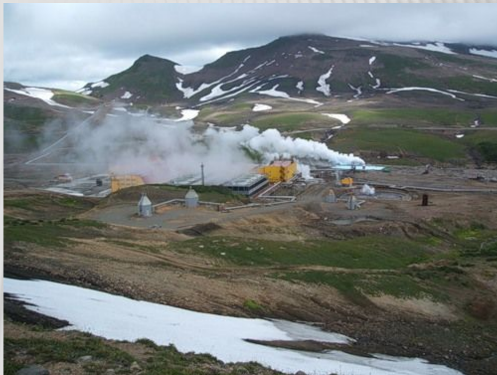
Мутновская геотермальная станция
