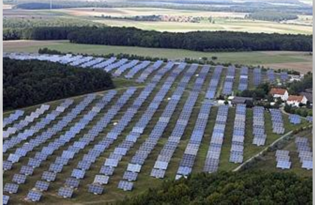
Солнечная электростанция в Германии
