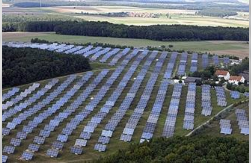
Солнечная электростанция в Германии
