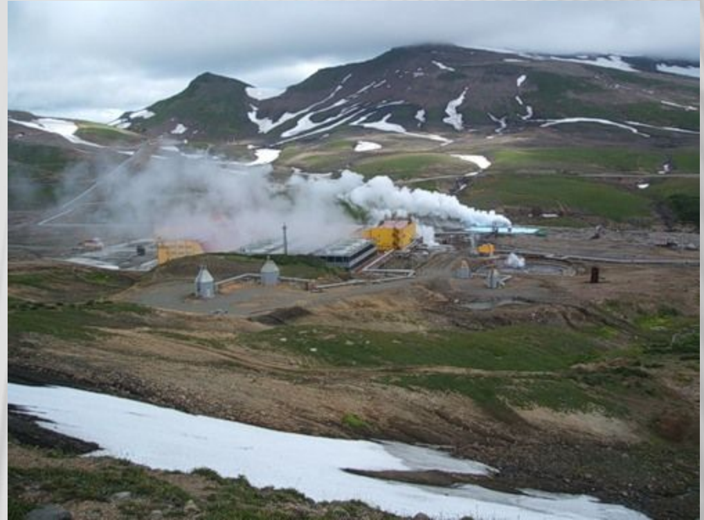
Мутновская геотермальная станция
