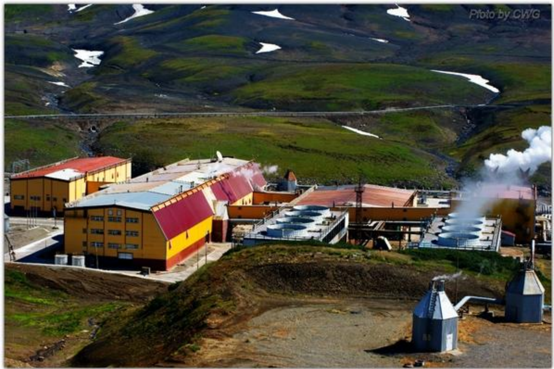
Камчатка - Мутновская Геотермальная электростанция
