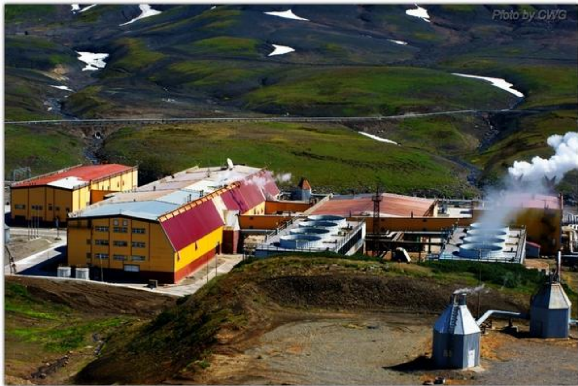
Камчатка - Мутновская Геотермальная электростанция
